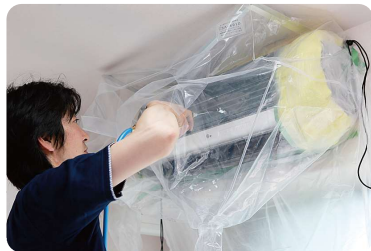
しっかりと養生して内部を高圧洗浄。
