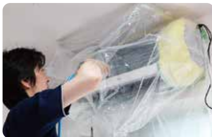
しっかりと養生して内部を高圧洗浄。
